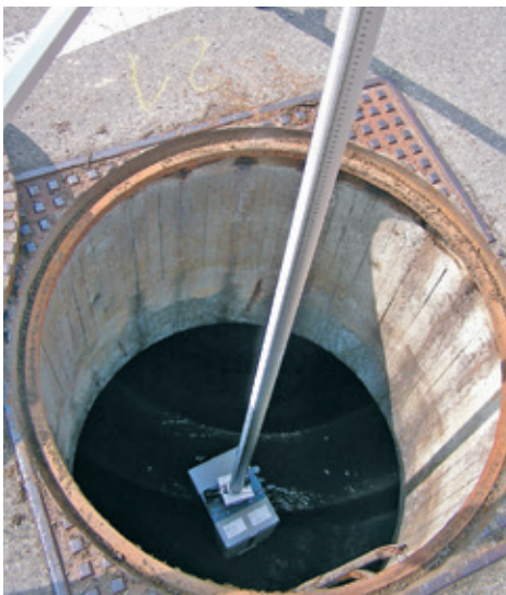
22-210 710 im Schachteinsatz: Der Scanner ist über den Adapter 22-660 040 mit dem Stativ verbunden.
