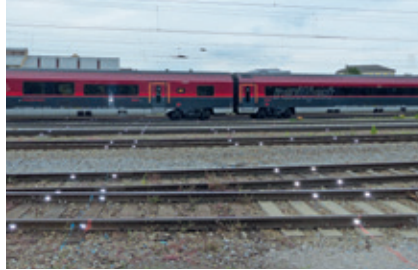
Überwachung einer Gleisanlage
