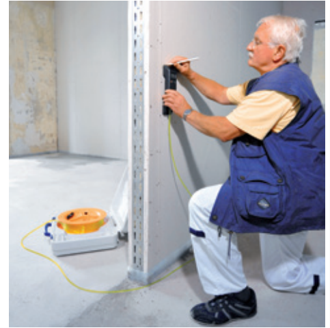
44-NIVCOMP im Einsatz: hier beim problemlosen Übertragen von Meterrissen im gesamten Geschoss. Anzeige „0“: Gerät ist auf exakt richtiger Höhe.
