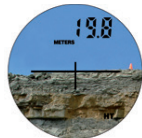
Anzeige Höhenmessung einer Abbruchkante mit TruPulse
