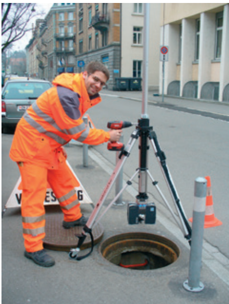
22-210 710 mit optionalen Rollfüßen und Faro-Scanner kurz vor dem Absenken des Scanners mit einem Akkuschauber (nicht im Lieferumfang).
