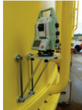
Magnetkonsole an Windkraftturbine
